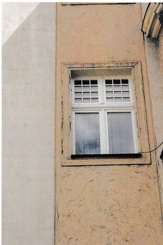
Fot.17. Spękania opasek okiennych – elewacja frontowa od strony zachodniej.
