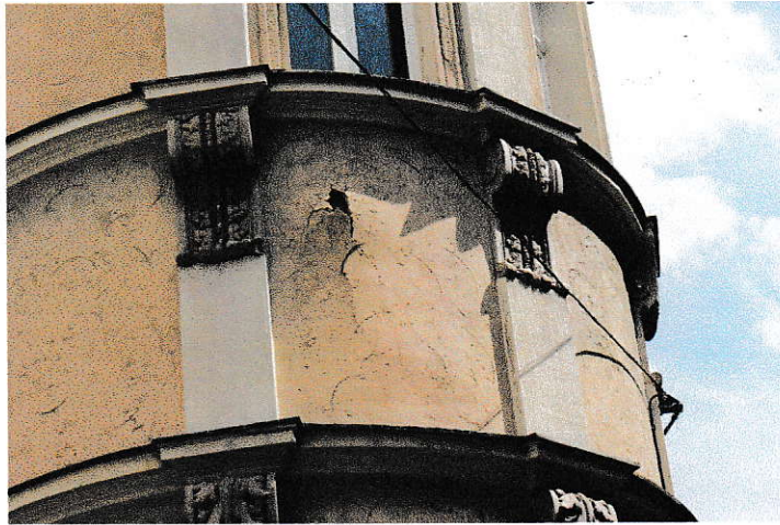
Fot.15. Uszkodzenia wypraw tynkarskich na wieży,
