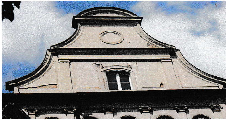
Fot.12. Naczółek elewacji frontowej -widoczne uszkodzenia wypraw tynkarskich.
