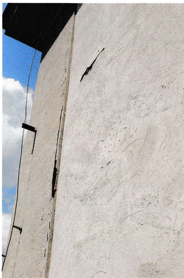
Fot.19. Destrukcja tynków na licu i narożniku elewacji zachodniej nad tarasem I piętra.
