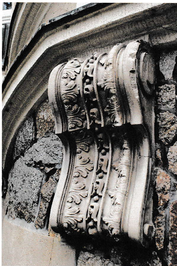
Fot. 20, Fot. 21. Detal sztukatorski wykonany ze sztucznego kamienia (elewacja frontowa).
