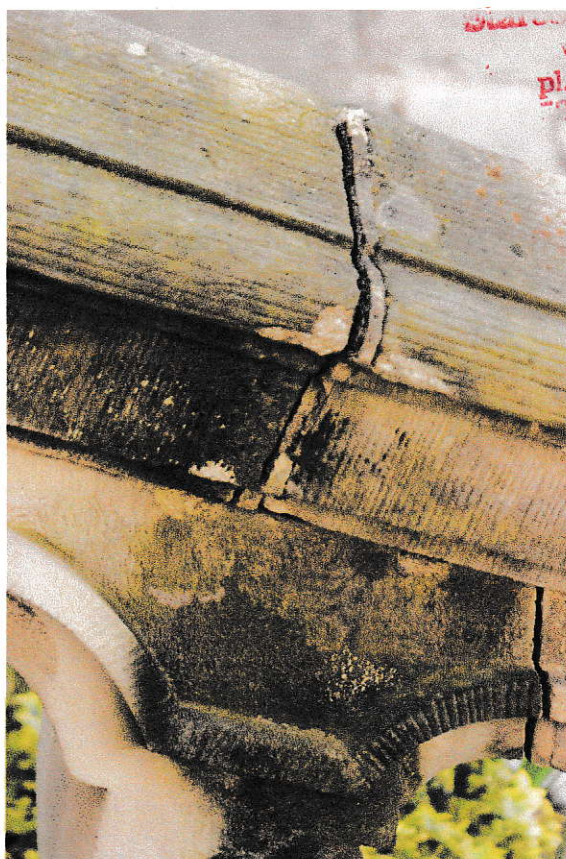
Fot.17. Spękania opasek okiennych – elewacja frontowa od strony zachodniej.
