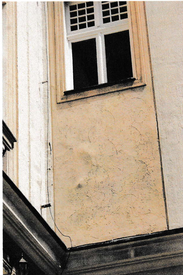
Fot.16. Uszkodzenia wypraw tynkarskich na licu elewacji frontowej od strony zachodniej.
